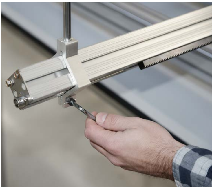
A kábeltartó rögzítése
