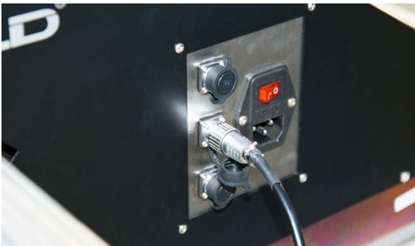
Az emelőmotor mágnesszelepkábelének csatlakoztatása
